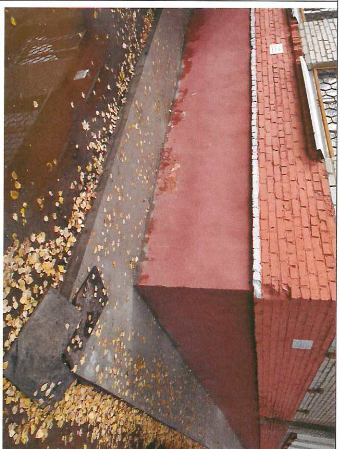
После окончания текущего ремонта цоколя и отмостки здания МБУ «Спортивная школа олимпийского резерва «Химик»
