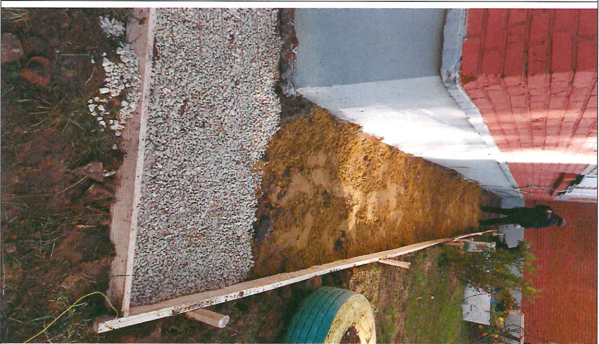
Выполнение работ по текущему ремонту покрытия и отмостки здания МБУ «Спортивная школа олимпийского резерва «Химик»
