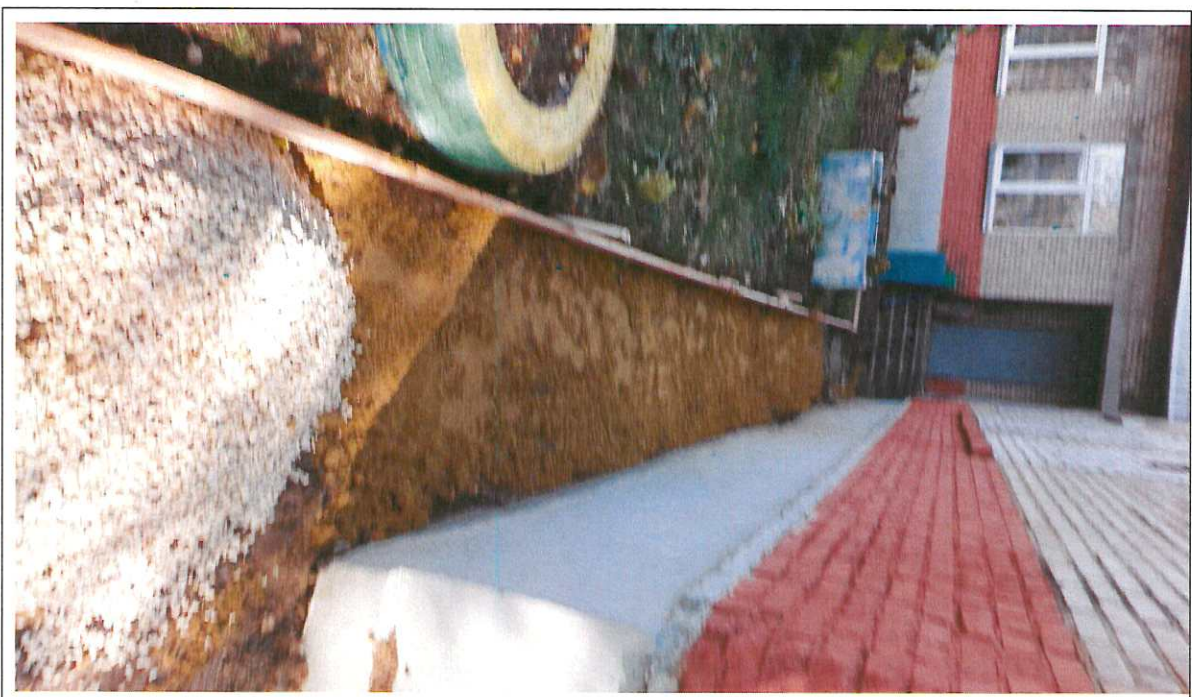
Выполнение работ по текущему ремонту покрытия и отмостки здания МБУ «Спортивная школа олимпийского резерва «Химик»
