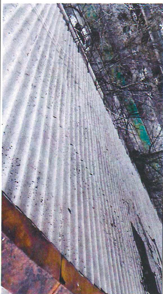
Фотографии объекта до начала работ
