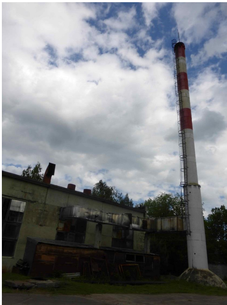
Рисунок 10 - Внешний вид котельной
