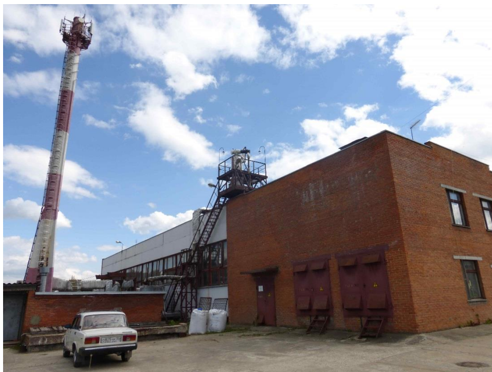
Рисунок 8 - Внешний вид котельной
