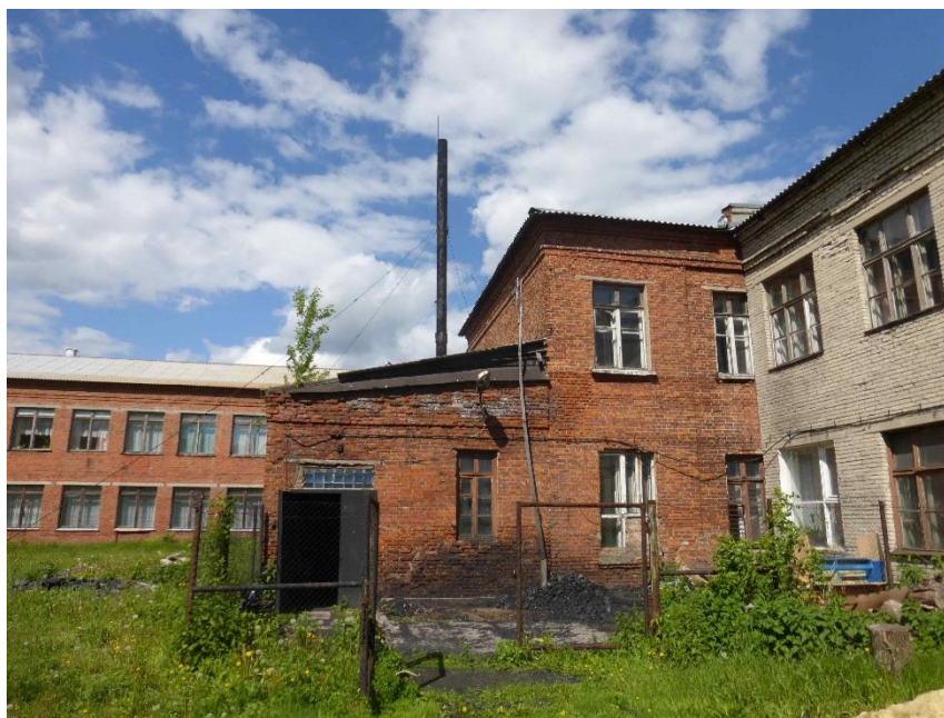
Рисунок 9 - Внешний вид котельной
