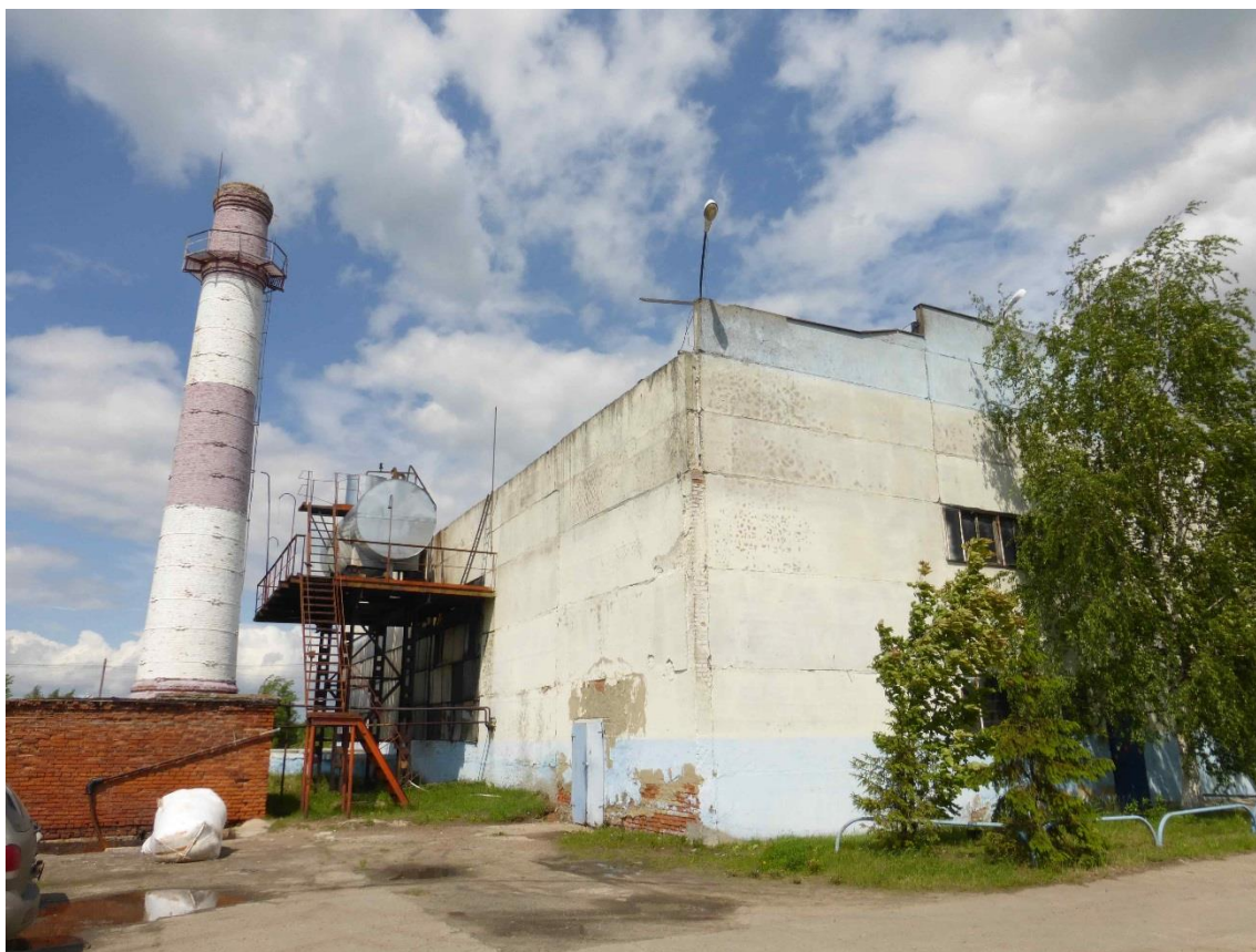
Рисунок 3 - Внешний вид котельной
