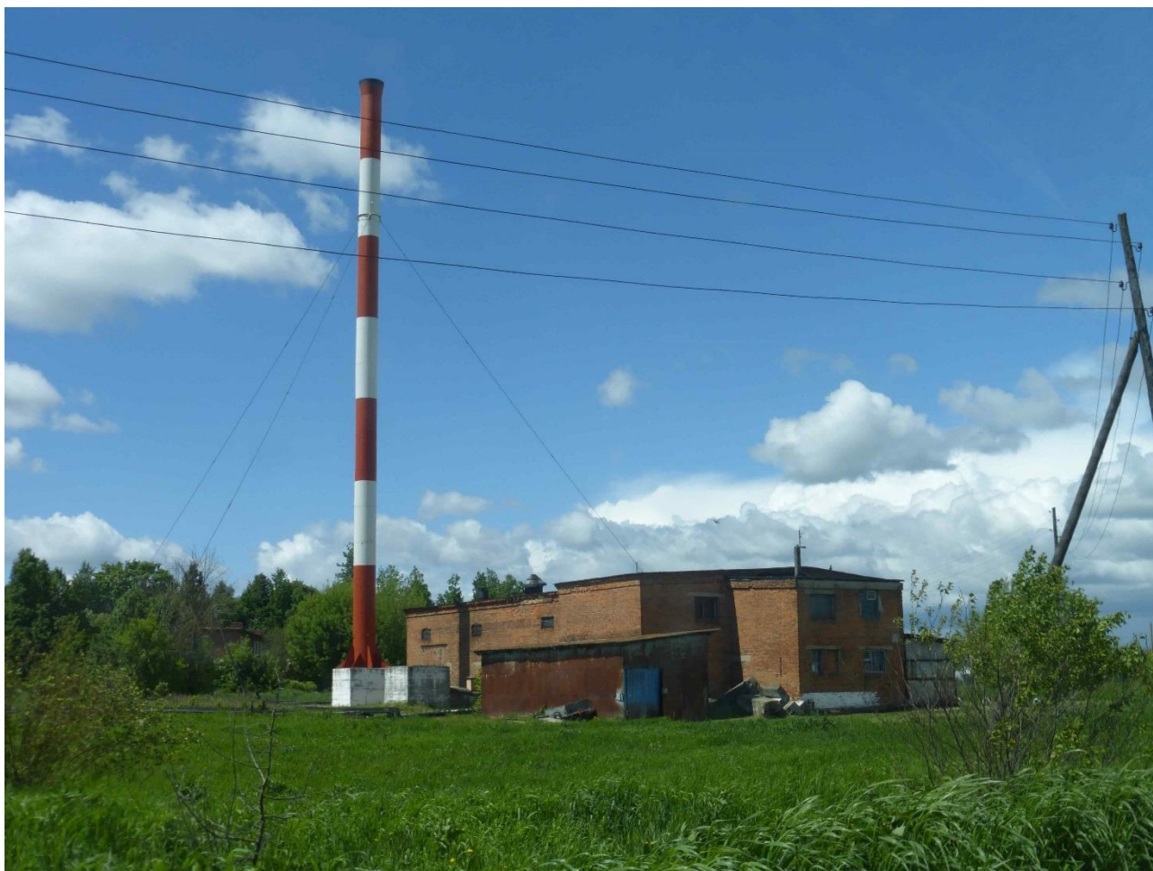
Рисунок 9 - Внешний вид котельной д. Ратчино
