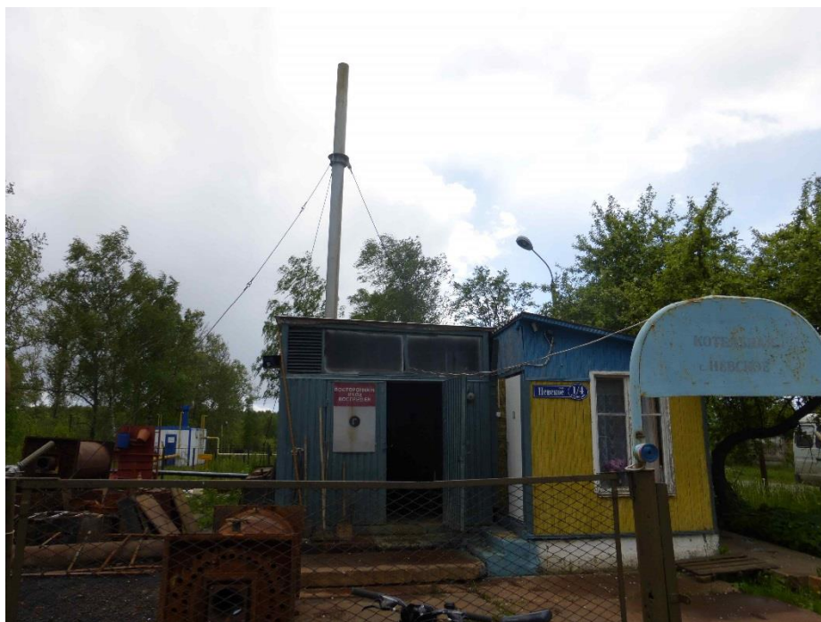
Рисунок 12. Внешний вид котельной с. Невское
