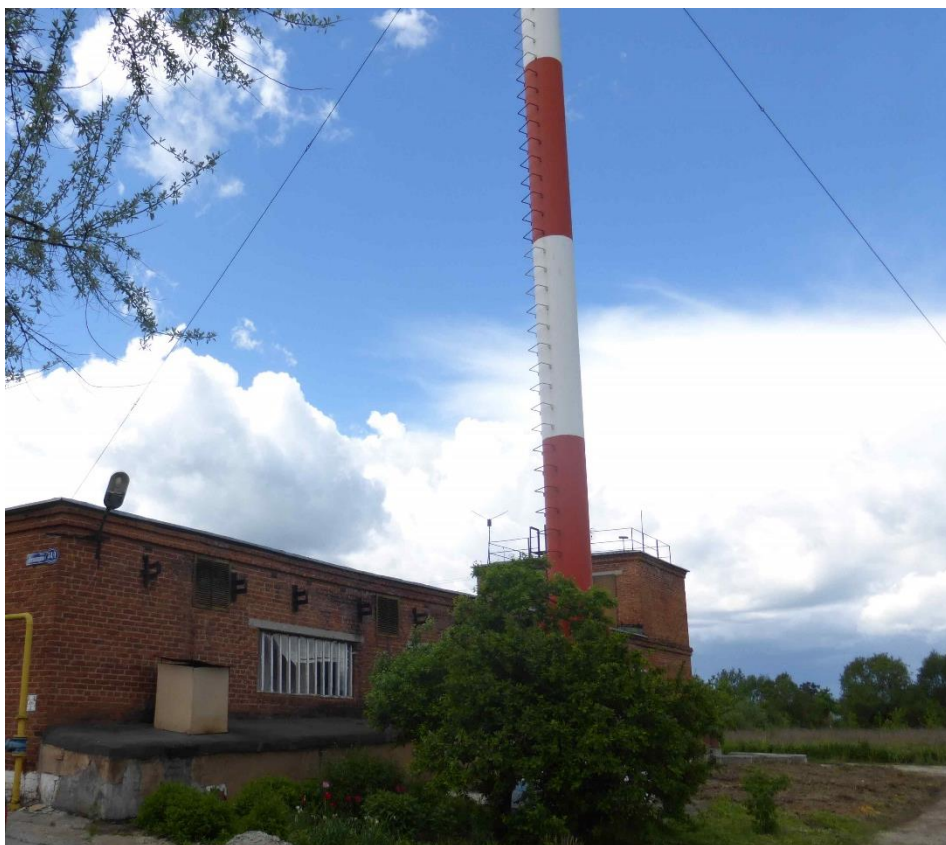
Рисунок 10 - Внешний вид котельной д. Степанщино
