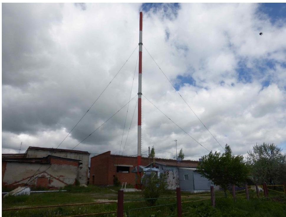
Рисунок 11 - Внешний вид котельной с. Косяково
