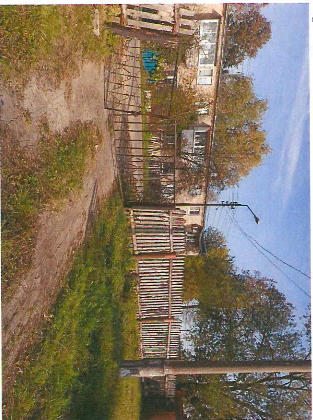
Отраждение здания МОУ «Москворецкая гимназия» до ремонта
